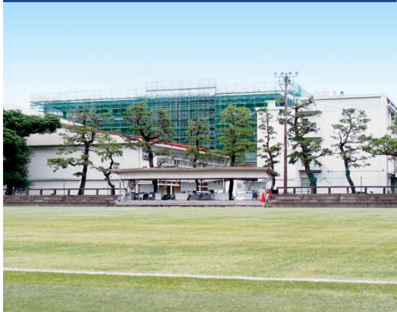
着々と建設が進む新校舎を人工芝グラウンド越しに望む。鉄骨造り5階建てで、来年2月に完成、4月に供用を開始する=9月6日撮影
